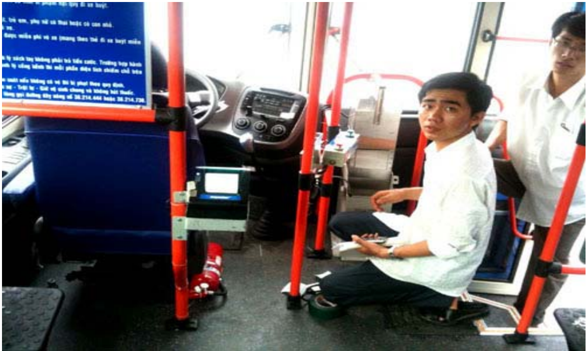
Các kỹ thuật viên của công ty Davisoft đang tiến hành lắp đặt hệ thống lấy số tự động trên xe bus
